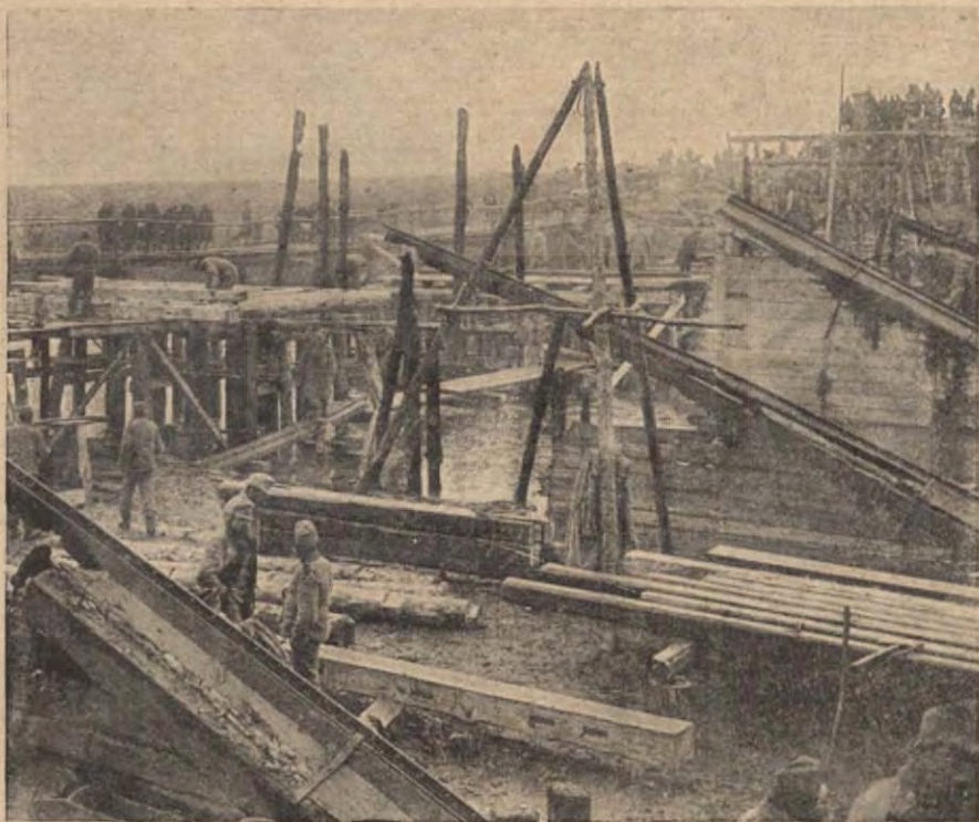
Facölöpökből összeállított híd a Dunajec-folyón, Galiciában. A mi hidász-csapataink két nap alatt megcsinálják az ilyen hidat, amelyen a legnehezebb ágyukat is keresztül lehet vinni. Az orosz hidászoknak ehhez legalább egy hét kellett.
