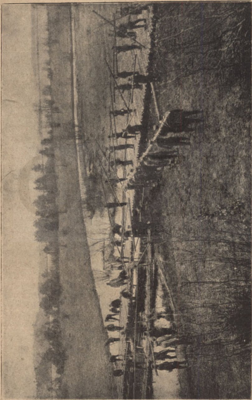
A műszaki csapatok hídát vernek a San folyón, hogy közeledő seregeink átkelhessenek a túlsó partra és folytathassák az oroszok üldözését. Egy ilyen fahíd építésével műszaki csapataink alig két óra alatt készen vannak, ha erdő van közelben. Erdő pedig szerencsére majd mindenütt volt a folyók partjai mellett.
