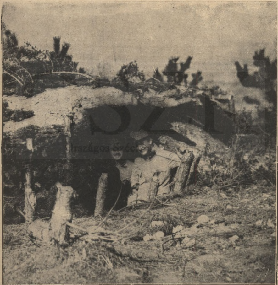
A lengyelországi harcokból : a srapel-biztos fedezék (lövőárkok) bejárata. A srapel a levegőben robbanó ágyugolyó, amelynek ezer és ezer szilánkja öli, sebesíti a katonát, ha eléri. Néha éppen az árok fölött robban a srapel és bizony nagy pusztítást tesz. Ezért néhol erős galyakkal, földdel beholtazzák az árok egy részét és a katonák odahúzódnak. Ott a srapel, ha robban is, legföljebb az ágakat törí össze.
