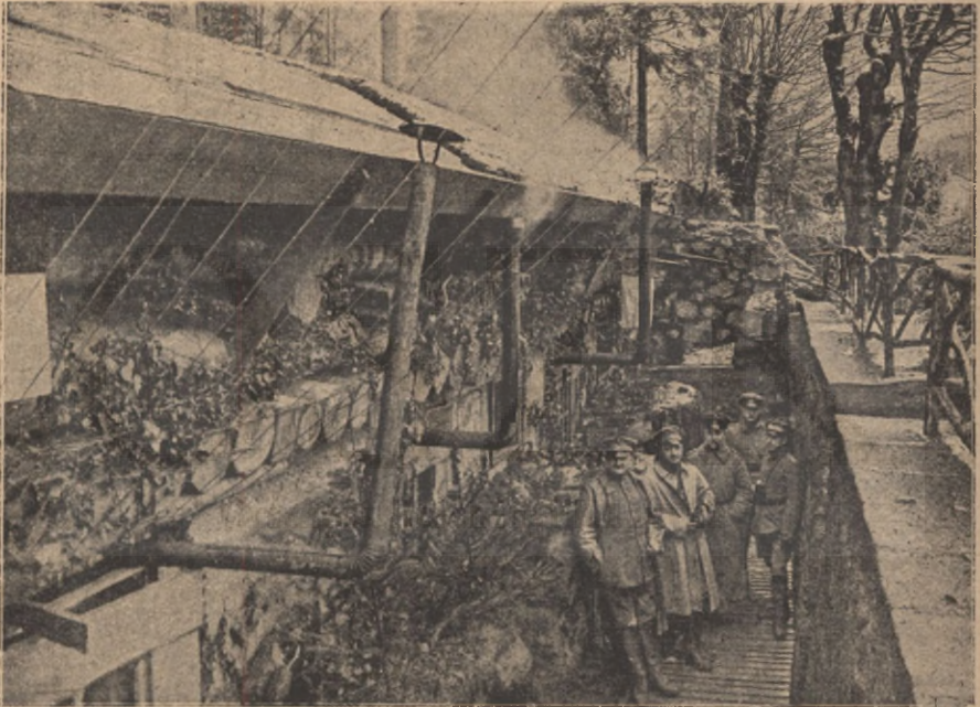
Lövészárók-palota a francia Vogézekben. A németek építették és több mint két eszten-deig laktak benne, mert sem őket a franciák, sem ők a franciákat onnan elűzni nem bír-ták. Ez a lövészárók olyan kényelmes volt, hogy igazán megérdemelte a palota nevet.
