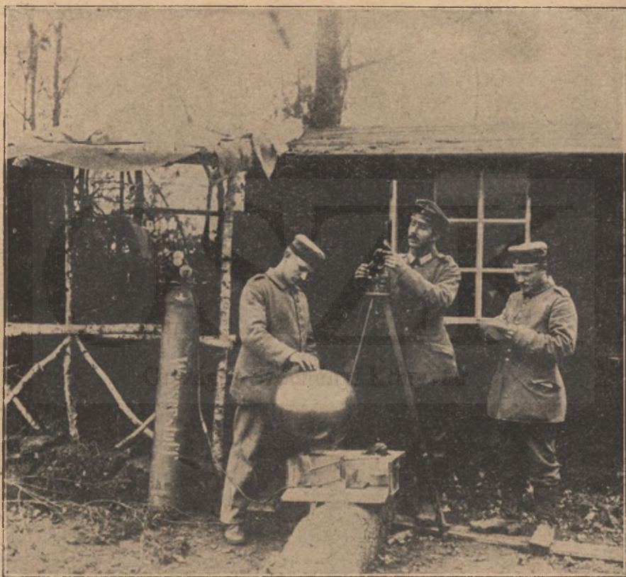
Német tábori időjelző-állomás a front mögött. Katonák gummi gömböt töltenek meg gázzal, hogy aztán fölengedjék a magasba és így meg lehessen figyelni a szelek irányát a felsőbb légrétegekben. A gépmadarak vezetőinek nagyon szükséges, hogy indulásuk előtt a szelek irányát és erejét ismerjék.
