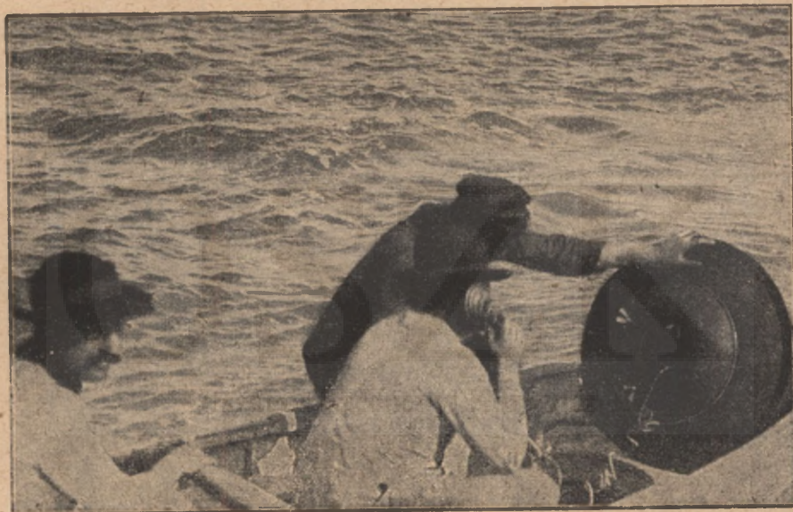
Telefonbeszélgetés a víz alá merült búvárhajóval. A búvárhajó, ha valami közömi valója van a tengerészeti parancsnoksággal, fölereszt egy bóját (drótra erősített tömlőt). Ehhez aztán csónakon odaéveznek, a bójába bekapcsolják a telefonkagylót és azonnal kezdődhet a beszélgetés.
